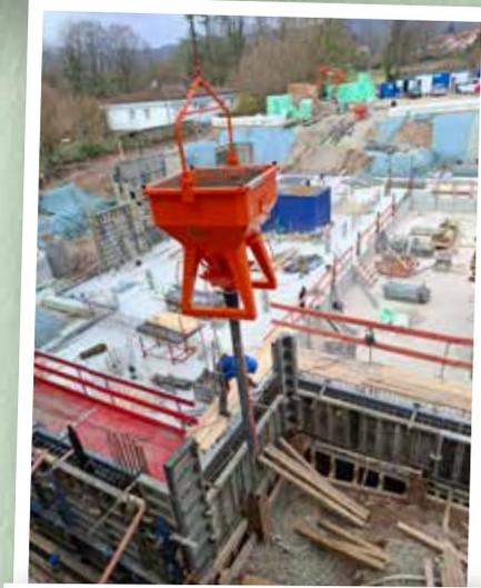
*Viele Wände werden aus Beton gegossen andere werden gemauert.*
