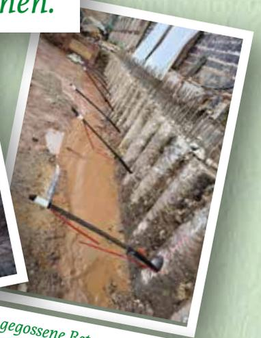
Neu gegossene Betonstützpfiler stabilisieren die Wand des Abtshauses..
