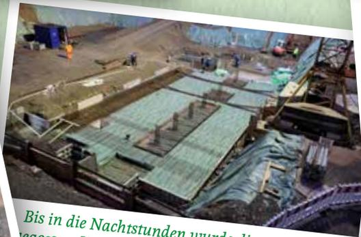
*Bis in die Nachtstunden wurde dieses Fundament gegossen. Vor dem Kälteeinbruch sollte es unbedingt fertig werden.*
