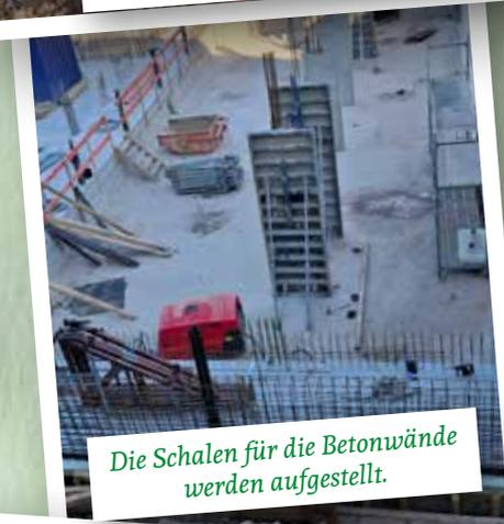
*Die Schalen für die Betonwände werden aufgestellt.*
