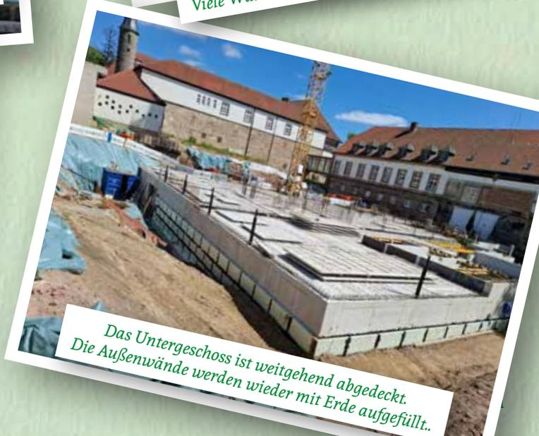
*Das Untergeschoss ist weitgehend abgedeckt. Die Außenwände werden wieder mit Erde aufgefüllt..*
