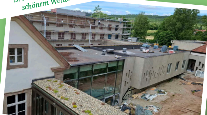
Über die Verbindungsbrücke gibt es einen guten Überblick über den Neubau: Der Bettentrakt im Hintergrund, vorn hinter dem Glas der zukünftige Kaffeetreff.
